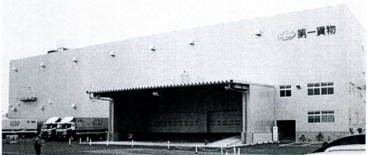
1日、新築・再稼働した仙台東倉庫
