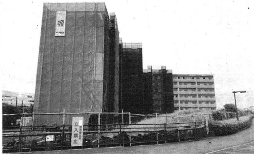
職場・住環境の改善に向け東京都江戸川区などに社宅を建設
