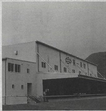
第一貨物の静岡支店
