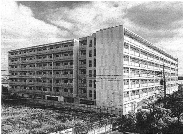
新・東京社宅の外観
