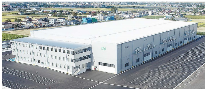
ドライバーの仮眠室や女性用シャワー室も完備した新・山形支店
