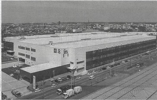
札幌物流センターが入居するDPL札幌レールゲート
