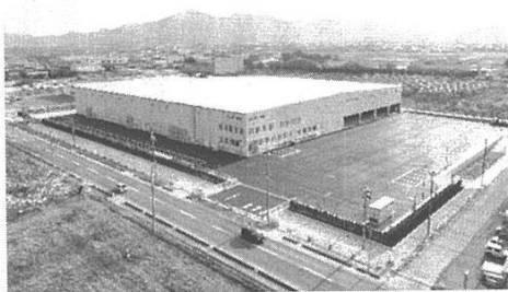
新倉庫の外観
